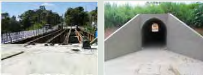
Passagem inferior para pedestre em Divinópolis Construção de Ponte.
