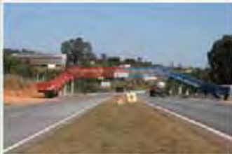
Passarela instalada em Mateus Leme
