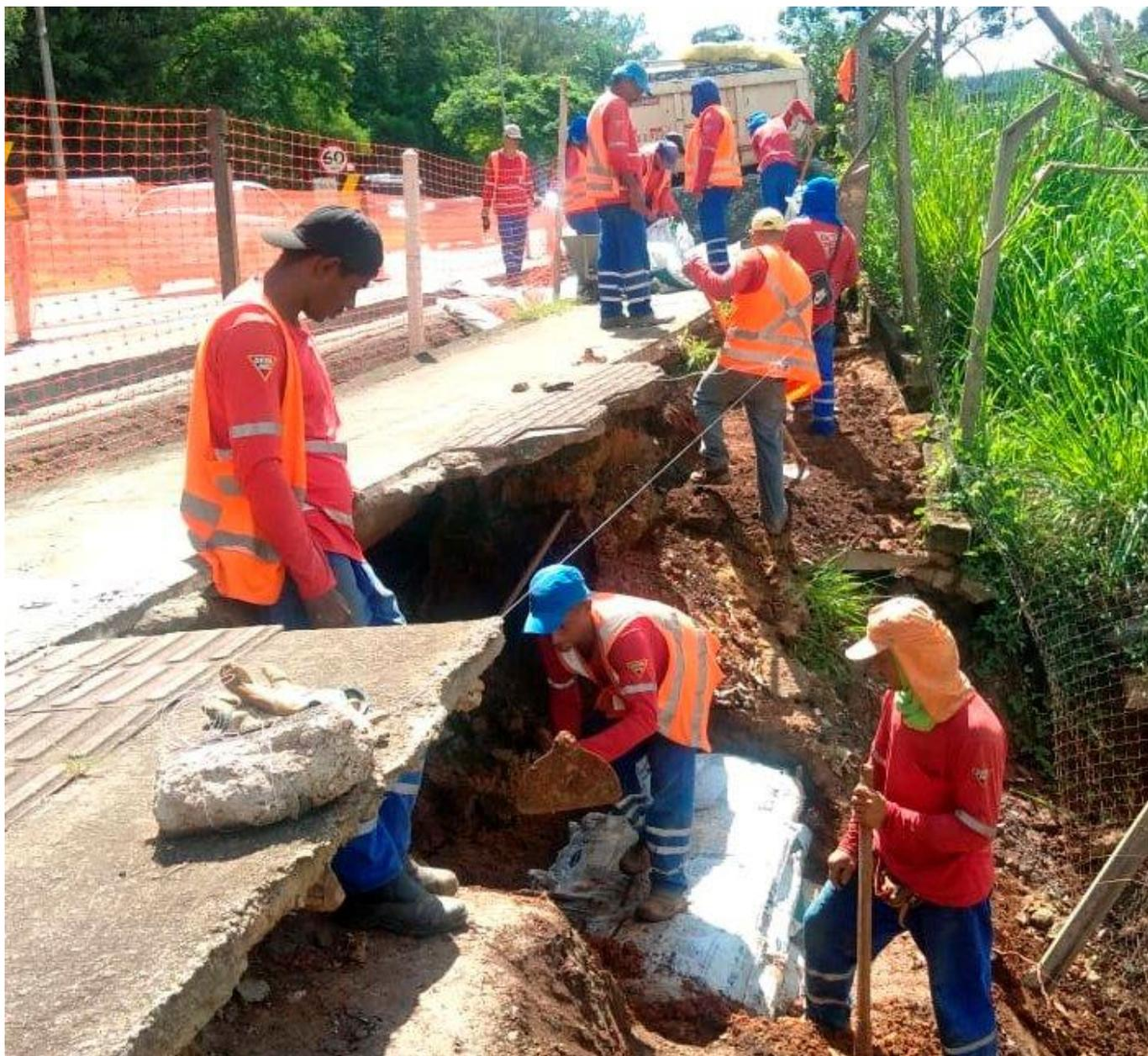
O local está sinalizado e já recebe uma solução emergencial de proteção até que o solo fique estável. Paralelamente, foi iniciado o levantamento topográfico e de sondagem da área, que permitirá a elaboração de um projeto básico de contenção.
